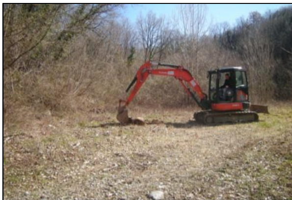
Lokacija sondažnega razkopa R3.
