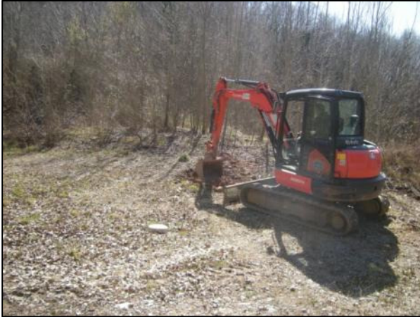
Lokacija sondažnega razkopa R4.
