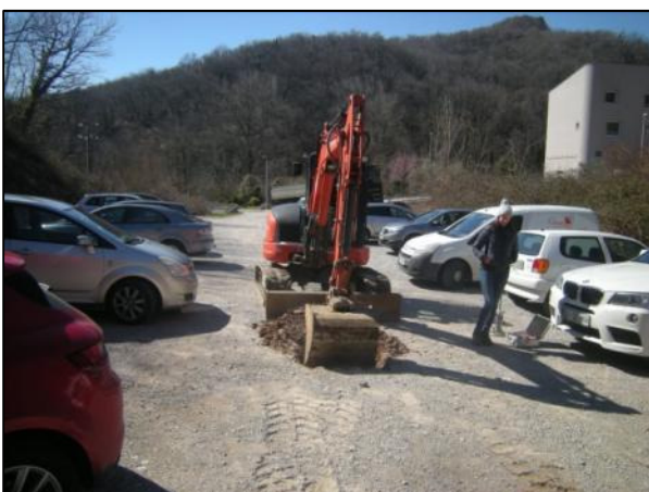
Lokacija sondažnega razkopa R6.
