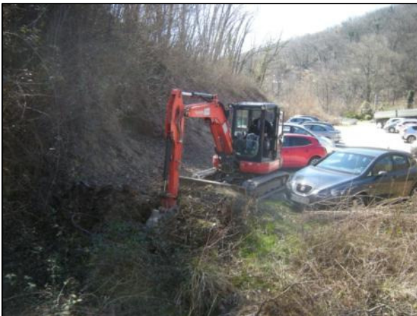
Lokacija sondažnega razkopa R5.
