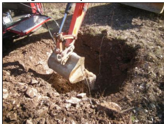
Sondažni razkop R1: nasip iz zaglinjenega gruščča, izvedba nalivalnega poskusa.
