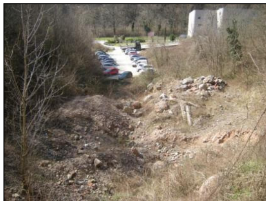
Zasuta struga potoka Bruljing z gruščem in večjimi skalami, gradbenimi odpadki.
